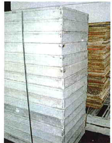
MASTER-Schalung Schalhaut ausgebaut, gereinigt, Ecken geschweißt
